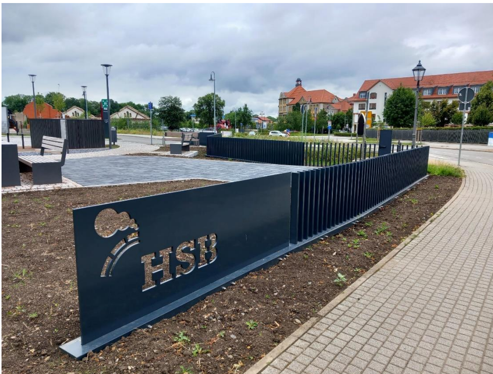
Abbildung 2 Ansicht vom Fußweg "Unter den Zindeln"
